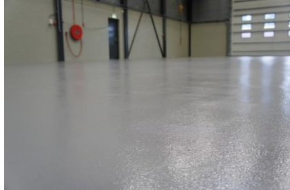
Boden Technikraum – Epoxyboden RAL 7000
