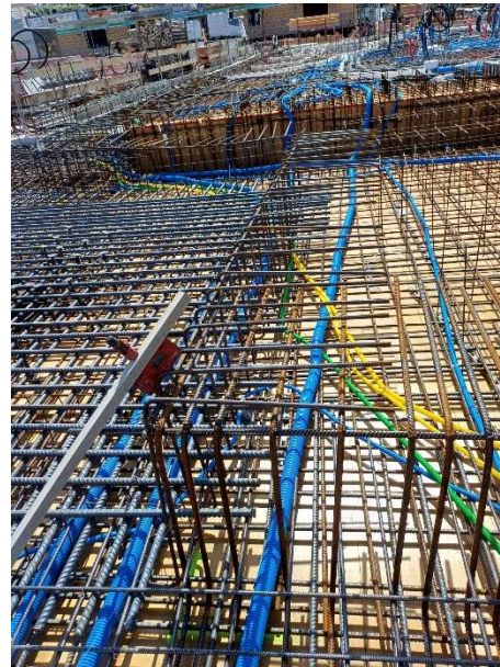
Abbildung 11 Decke UG 6.Et (eigene Aufnahme)
