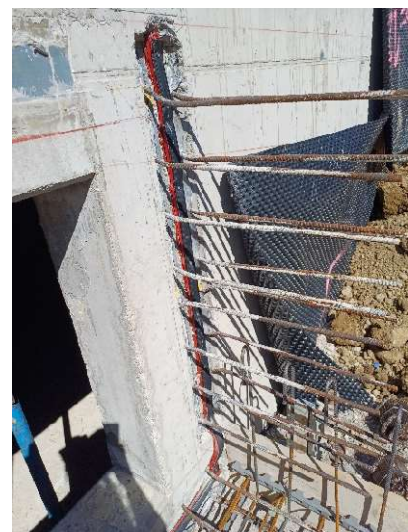
Abbildung 8 Bewehrungsanschluss (eigene Aufnahme)
