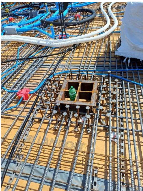
Abbildung 13 Decke UG 7.Et (eigene Aufnahme)
