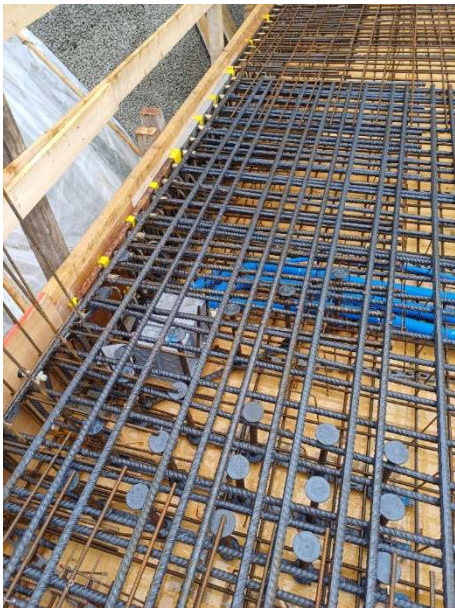
Abbildung 12 Decke UG 1.Et (eigene Aufnahme)
