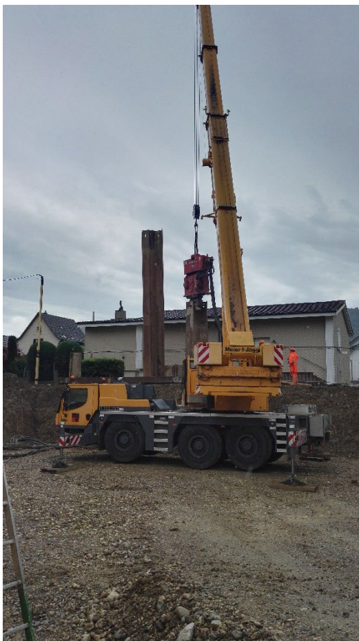
Abbildung 17: Einbau von Spundwand, Foto Büro
