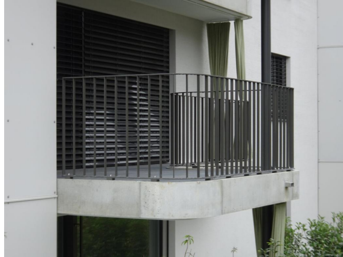
Produkt: Staketengeländer, anthrazit Einsatzort: Balkone (11)
