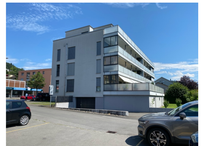
Nachbargebäude Südost auf Parz. 659 (3)
