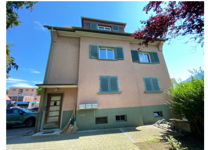
Ansicht Nordwest-Fassade mit Hauseingang (3)
