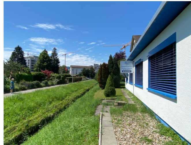
Ansicht Südwest-Fassade mit Dorfbach (3)
