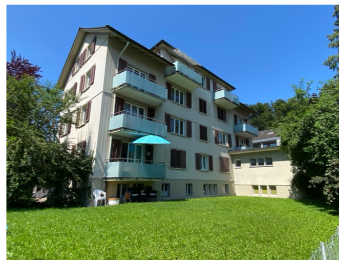
Nachbargebäude Nordwest auf Parz. 733 (3)
