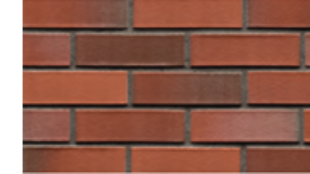
Fassade Obergeschoss Zweischalenmauerwerk Sicht Klinker Rot ASP-321
