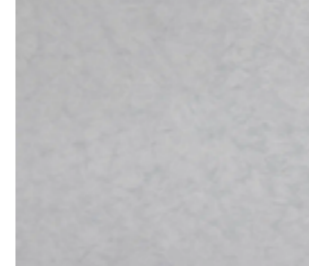
Fassade Sockelgeschoss Glasfaserbeton CEMFOR sangestrahlt, Farbe S621
