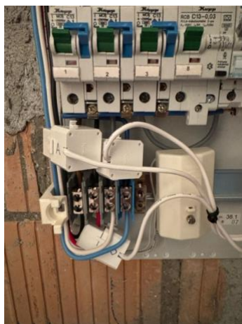
Abbildung 16-Stromwandler Shelly Devices
