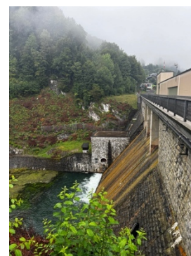
Bild 26: Staumauer am Sihlsee
