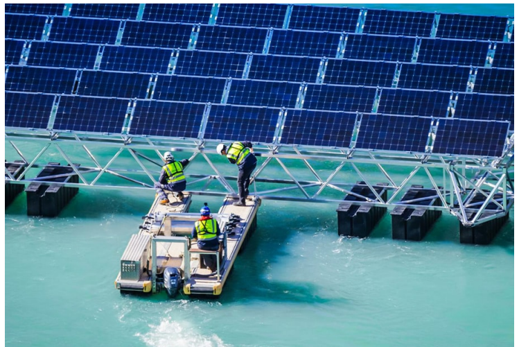
Bild 2: Installation der Unterkonstruktion von K2
