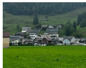
Bild 27: Viele Häuser mit Sicht auf den Sihlsee
