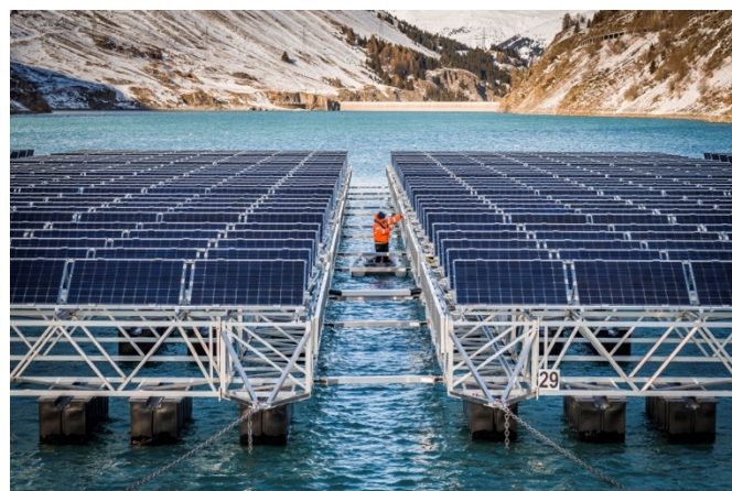
Bild 18: Installation auf dem See
