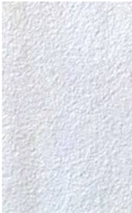
Innenwände Kirchengebäude verputzt und gestrichen, Farbe weiss
