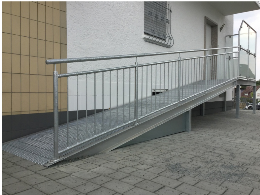
Rampe und Eingangsstufen in Metall
