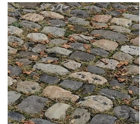
Natursteinpflaster aus Bestand
