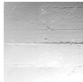
3 Wände Stahlbetonwände, gestrichen RAL 9016, verkehrsweiss
