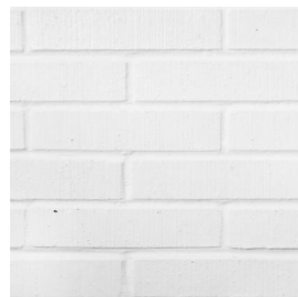
2 Wände Backsteinwände, gestrichen RAL 9016, verkehrsweiss
