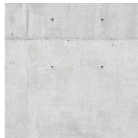
11 Rampe Sichtbeton Typ 2, farblos lasiert
