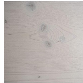
3 Decke 3-Schichtplatte, gestrichen RAL 9016, verkehrsweiss
