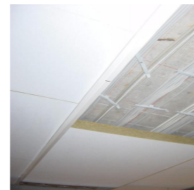
4 Decken Schallschutz-Deckendämmplatte Isover Topdec DP 3, weiss
