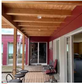
2 Vordach Bestehendes Vordach aus Holzelementbau
