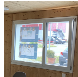
4 Fenster Bestehende Fenster Innen: Holz, weiss gestrichen
