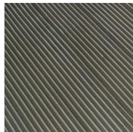
10 Rampenbelag Hartbeton, gerillt
