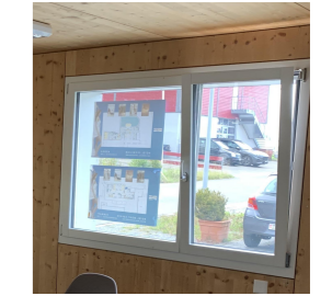
8 Fenster Bestehende Fenster Innen: Holz, weiss gestrichen
