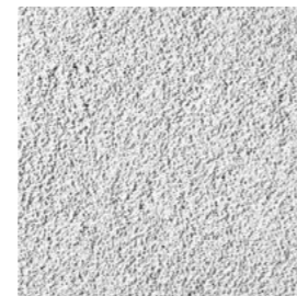
12 Kompaktfassade zu Einstellhalle Mineralischer Aussenputz RAL 7035, lichtgrau
