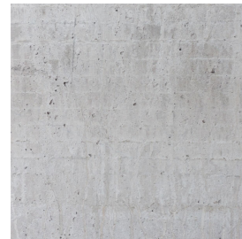
5 Stützen Stahlbetonstützen Sichtbeton, farblos lasiert
