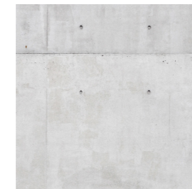
2 Wände und Decke Sichtbeton, farblos lasiert
