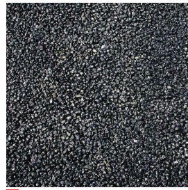
1 Erschliessung, Vorplätze Sickerspaltbelag
