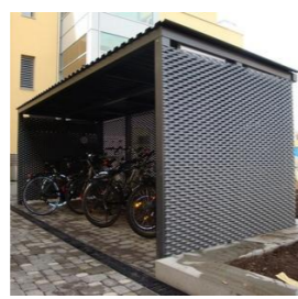
12 Velounterstand Streckmetall wie Fassade
