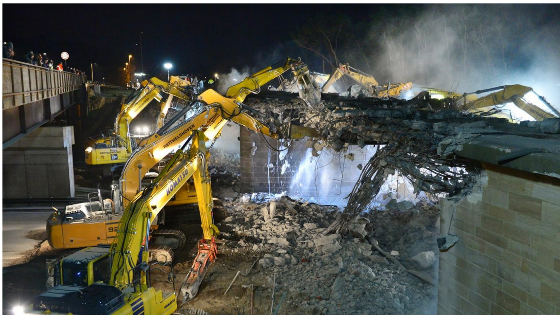
Abbildung 11-5, Abbruch einer Brücke bei Erlangen (DE), https://www.nordbayern.de/region/erlangen/a3-bei-erlangen-bruecke-uber-nacht-spektakular-abgerissen-1.7189694 , 20.09.2021
