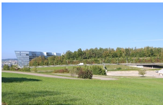
Abbildung 11-8, «Serpentinen» Fahrschulstrasse, Florian Sutter
