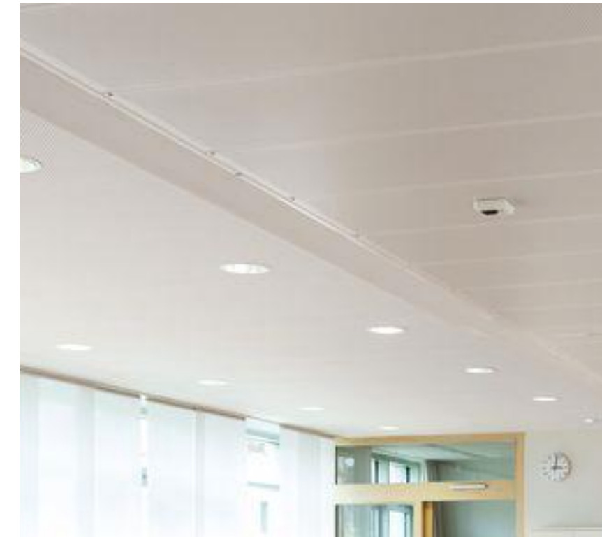
Heruntergehängte Decke
