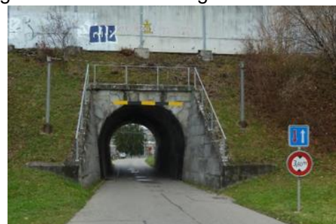
Abbildung 18: Ansicht Unterführung Riedmühlestrasse
