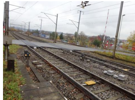
Abbildung 6: Ansicht Bahnübergang heute
