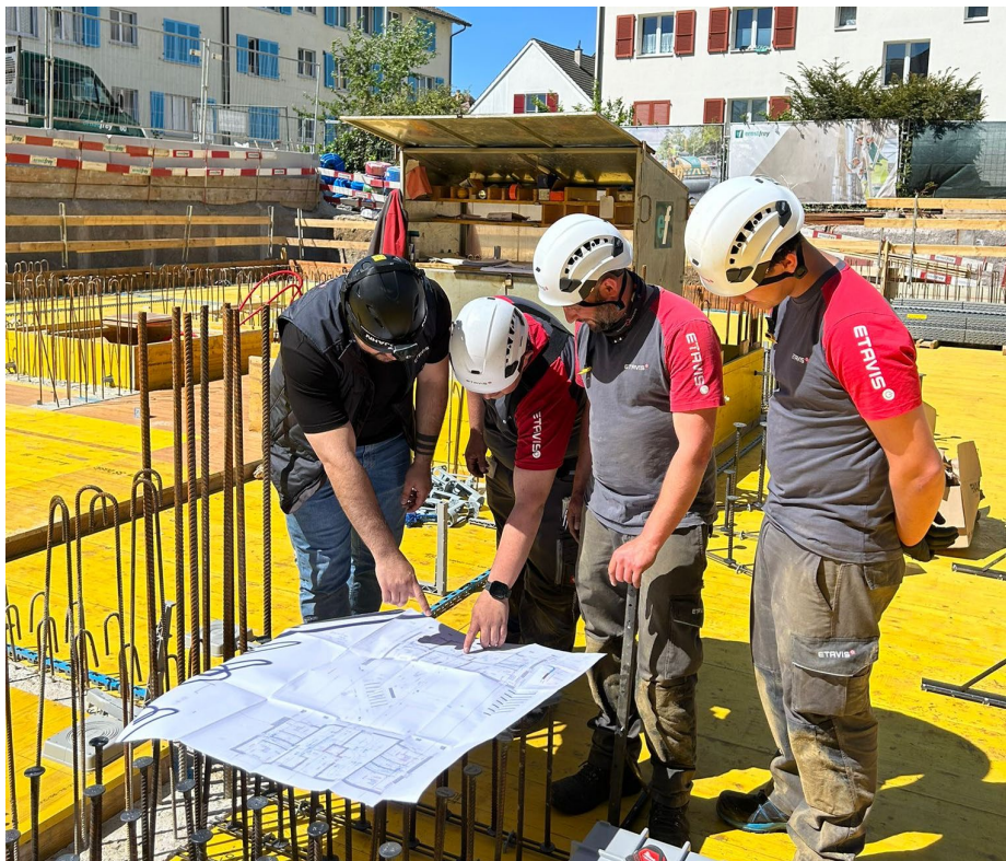
Abbildung 23: Anzeichnen mit Hilfe von Papierplänen
