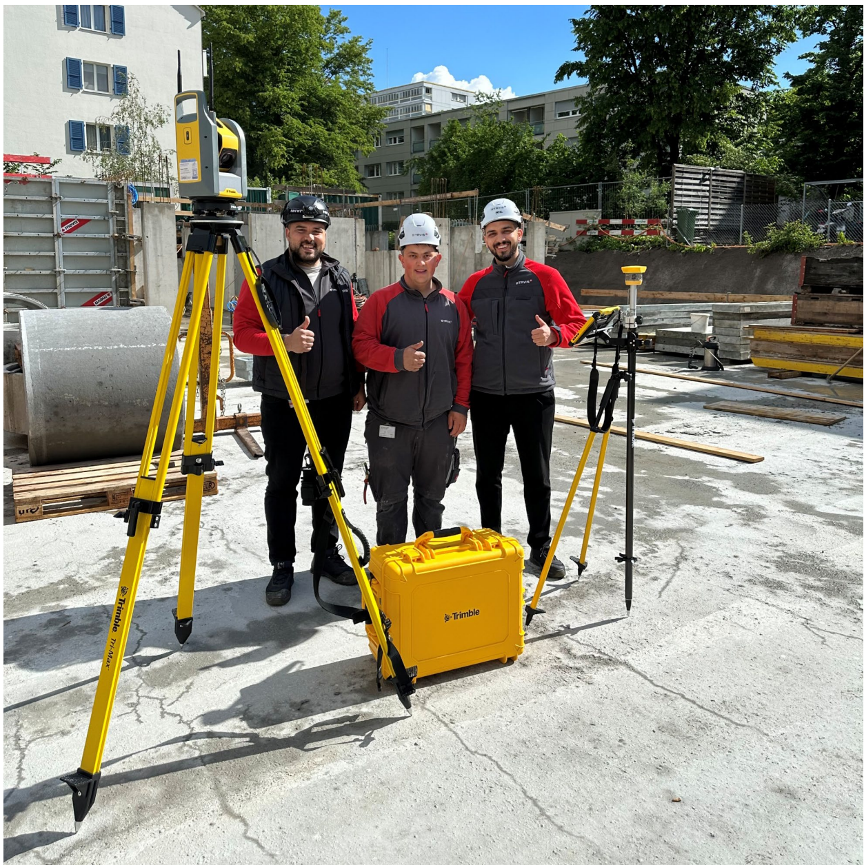
Abbildung 54: Totalstation auf der Baustelle
