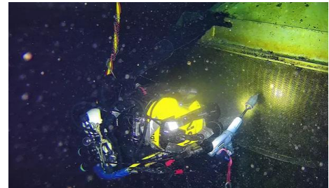
Abbildung 7: Ein Taucher der Quaggamuschnen mittels Hochdruckreiniger entfernt. (Südkurier, 2022)
