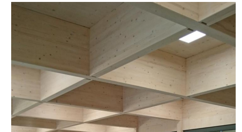
Holzträger aus Brettschichtholz
