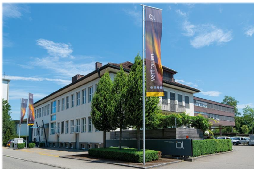
Abbildung 5-1, Firmengebäude IB Langenthal AG
