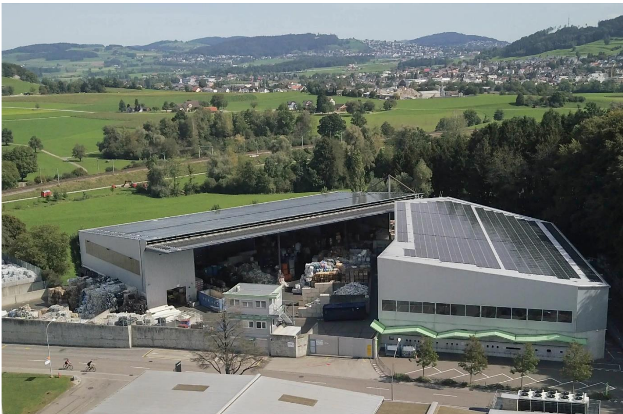
Abbildung 9; Einwurfsammelstelle und Sammelhalle von Inno Recycling
