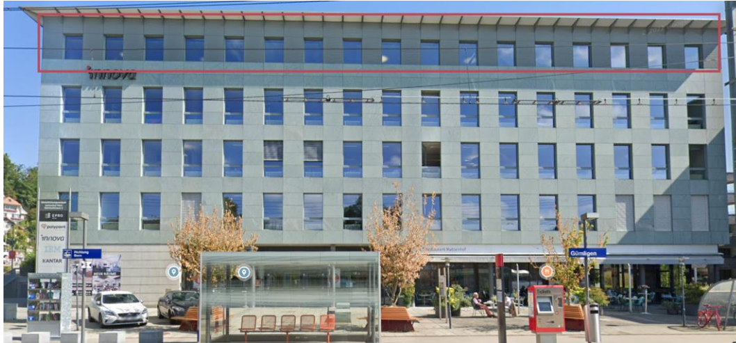
Abbildung 4-2 Bürogebäude, Bahnhofstrasse 4, 3073 Gümligen (Quelle: https://www.EPRO.ch/organisation/ )
