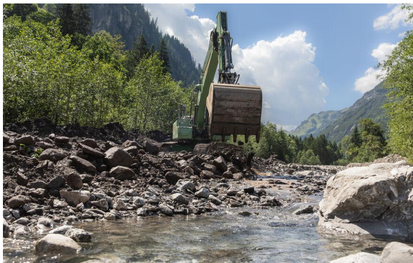
Abbildung 34 Revitalisierung der Gewässersohle
