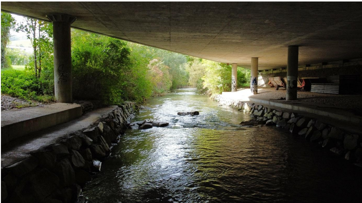
Abbildung 13 Kanalisierte Ergolz in Lausen (Quelle: Stephan Trippmacher)
