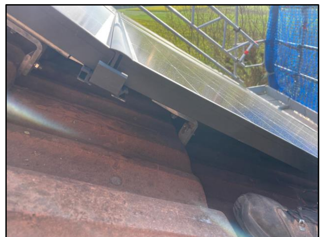
Abbildung 72: Dachhaken mit Modulverlegung (Foto von Smartphone)
