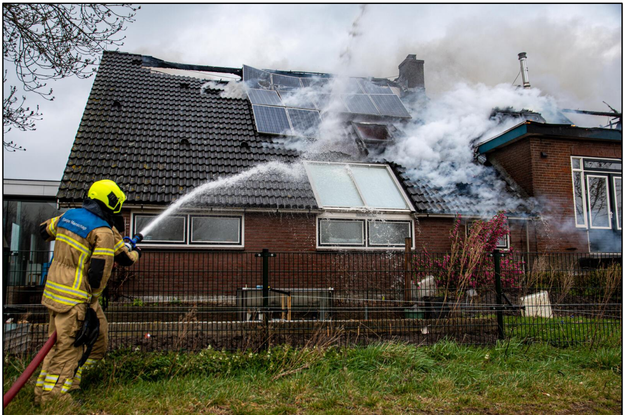
Abbildung 63: Brand einer Solaranlage (google.com)
