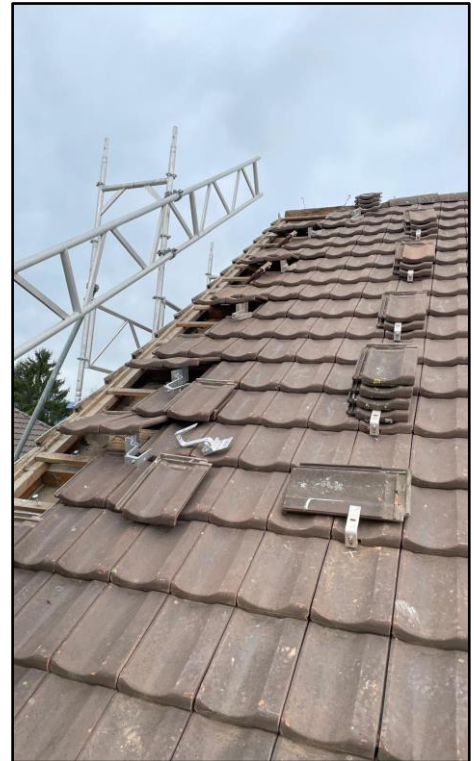
Abbildung 70: Kontrolle der UK (Foto von Smartphone)
