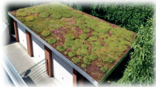
Flachdach extensiv begrünt
