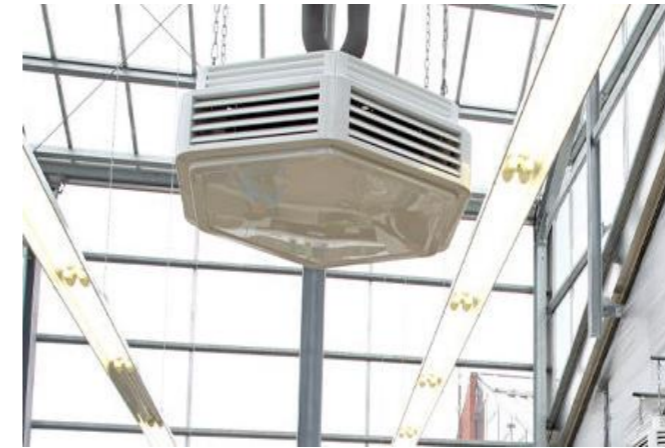
Abbildung 10: Umluftgerät
