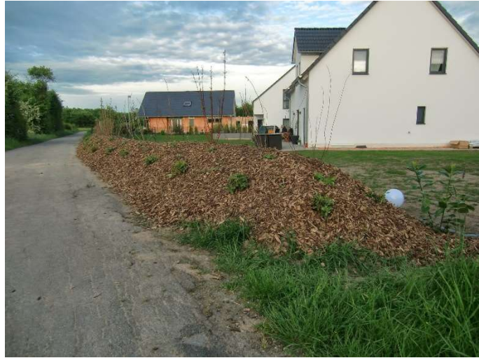
Abbildung 24: Beispielbild von Lärmschutz Erdwall (mein schöner Garten, 2023)
