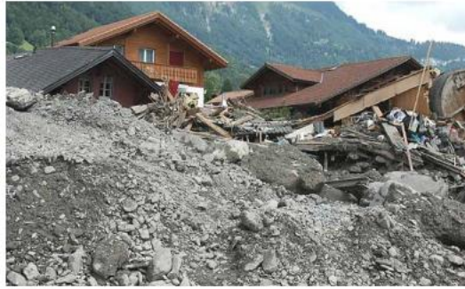
Abb. 2: Übermuring durch den Glyssibach in Brienz (BE) im August 2005 (Quelle: Beo-News)
