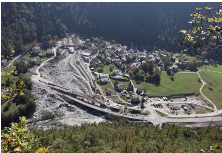
Abbildung 29 Schutzbauten Bondo (espazium.ch)
