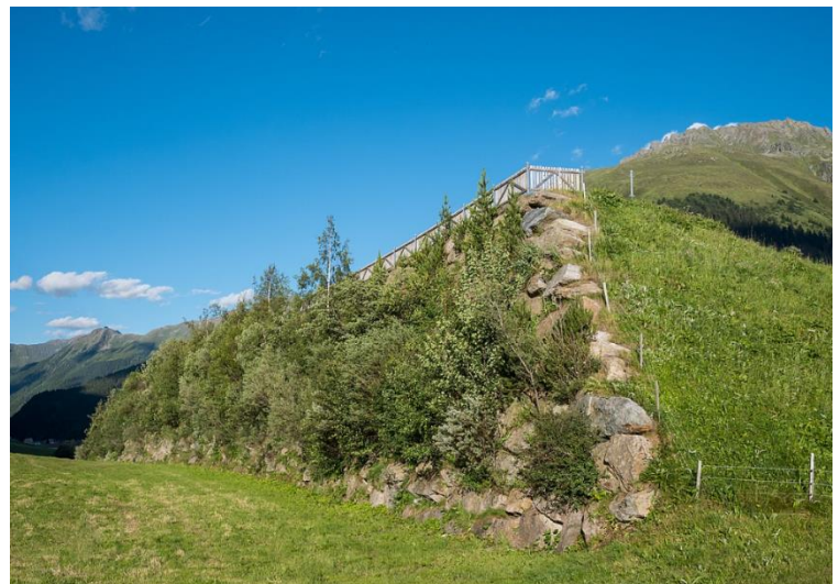
Abbildung 49 Schutzmauer unterhalb des Grieskogles (Wikipedia)
