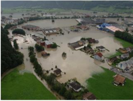
Abb. 1: Überschwemmung in Schattdorf (UR) durch Reuss, Schächenbach und Gangbach, August 2005 (Quelle: Kanton Uri)
