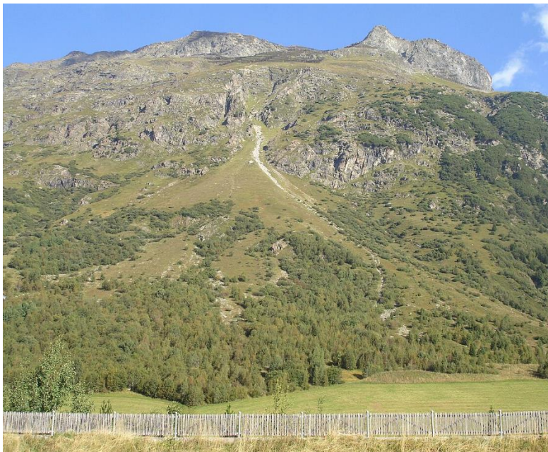
Abbildung 48 Schutzverbauungen Grieskopf (Wikipedia)
