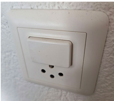
Abbildung 38 Schalter vor der Demontage
