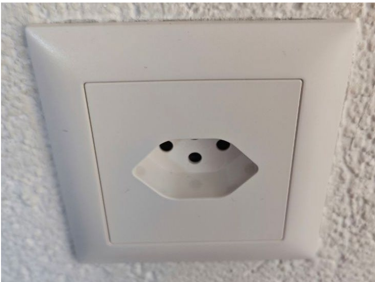
Abbildung 40 Endresultat des Schalterumbaus
