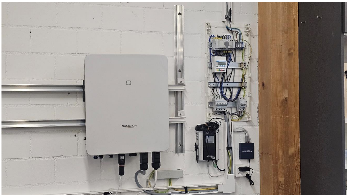
Abbildung 36: Übungswand im Servicebüro
