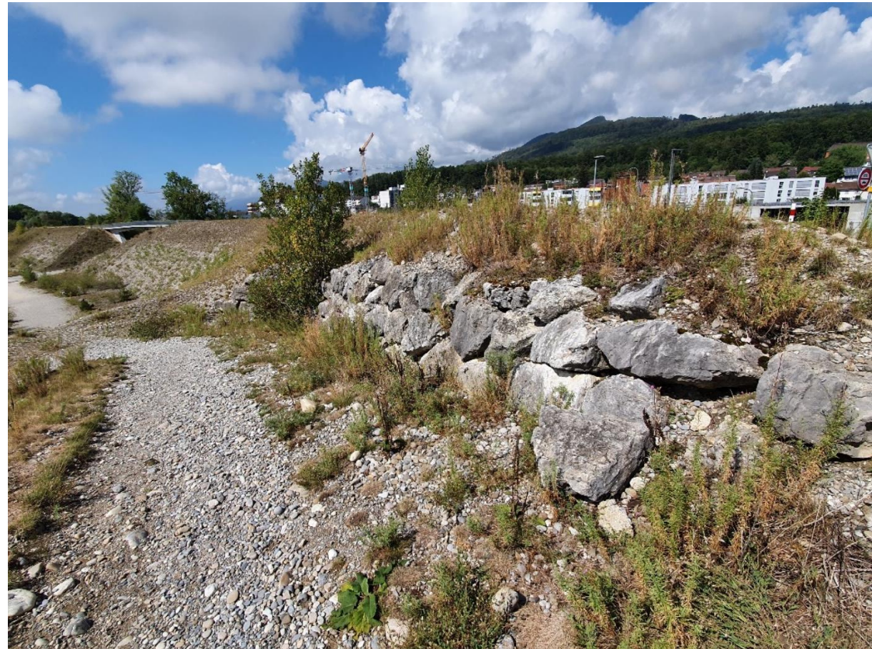
Abbildung 24 Trockenmauer Olten Südwest (eigene Darstellung)
