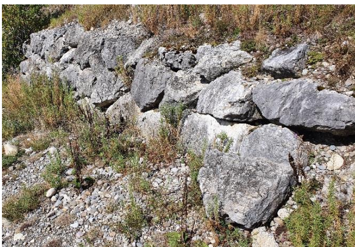
Abbildung 3 Trockenmauer im Gebiet Olten Südwest (eigene Darstellung)
