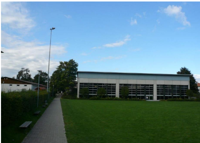
Bild 5: Blick vom Türmlischulhaus auf die Turnhalle und den Musikpavillon.
