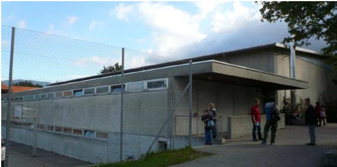
Bild 10: Blick auf den Zugangsbereich des Heizraumes der Turnhalle. Sichtbar ist der Kamin der bestehenden Ölheizung.
