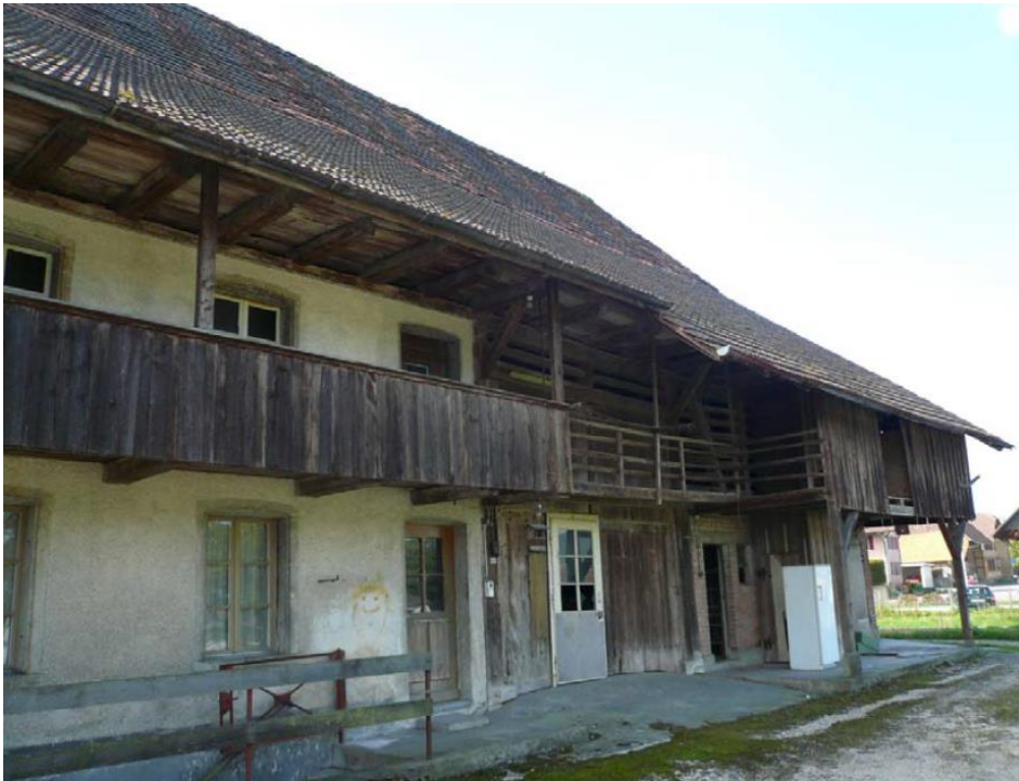
Bild 8: Ein idealer Standort einer Holzschnitzel-Heizzentrale befindet sich beim Kocher-Büetiger-Haus an der Aarbergstrasse 23.
