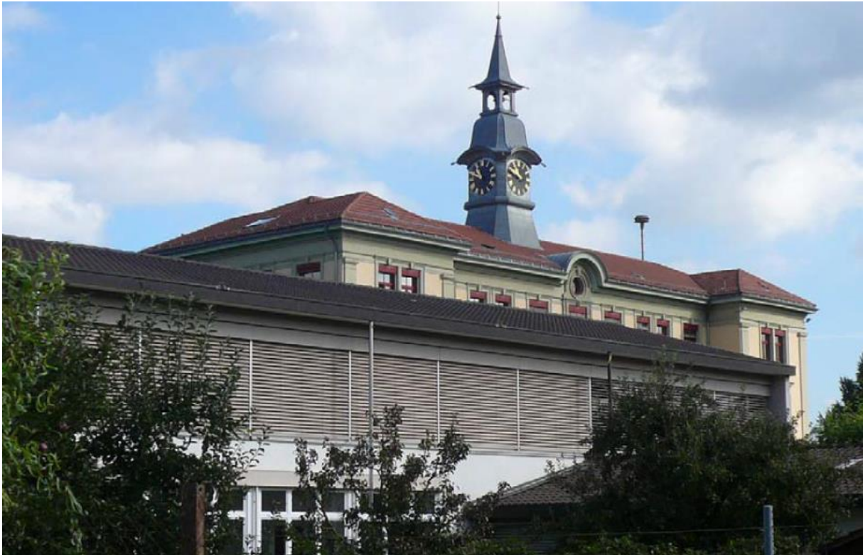
Bild 3: Blick von Südwesten her auf das Oberstufenschulhaus und das dahinterliegende Türmli Schulhaus mit der Heizzentrale für beide Gebäude.
