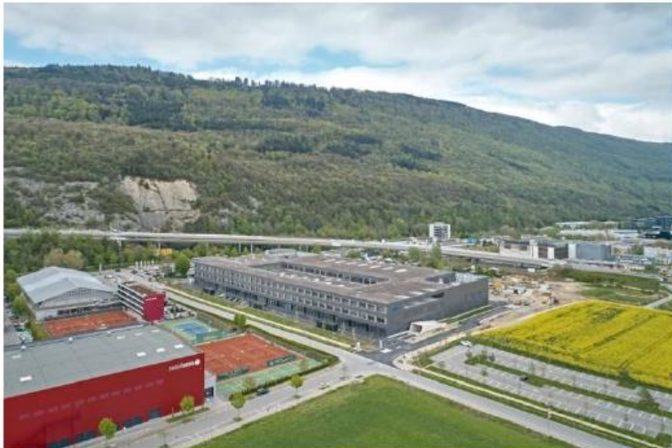
Abbildung 1 Die neue Zentrale von GF Machining Solutions in Biel von oben gesehen. (GF Machining Solutions AG, 2020)
