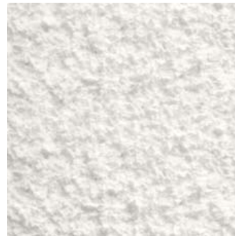
Decke Akustikputz bestehend Weiss RAL 9016
