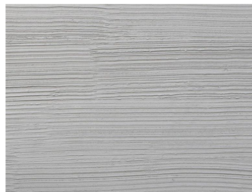
Beton Besenstrich Betonoberflächen Treppe + Rampe
