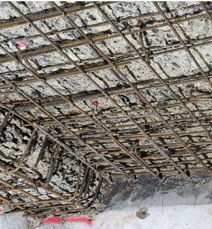
Beispiel Hydrodynamischer Betonabtrag an Unterarmierung
