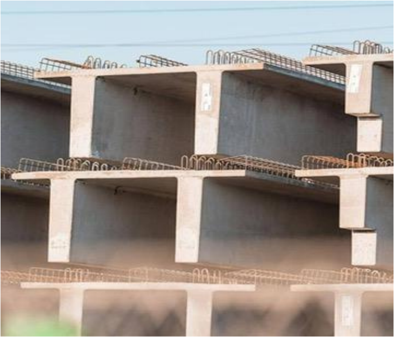
Vorgefertigte Rippendecke
