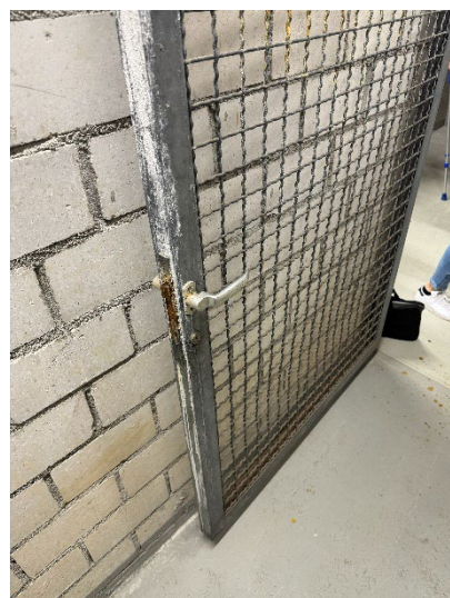
Abbildung 3: Korrodierte Stahltür
