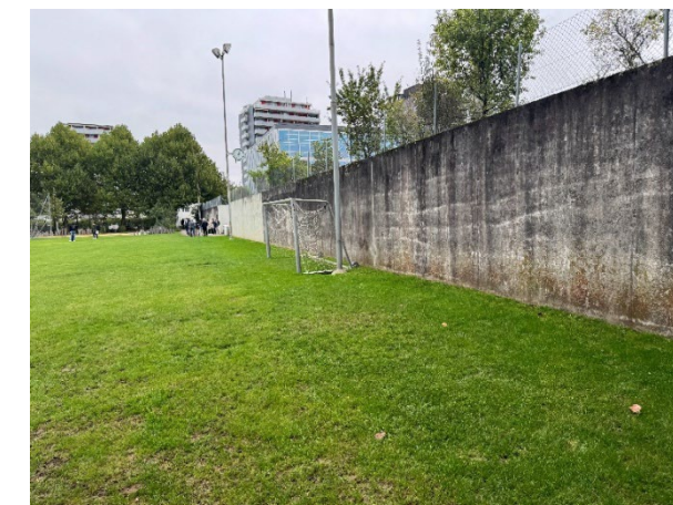
Abbildung 26: Stützmauer von Hartplatz
