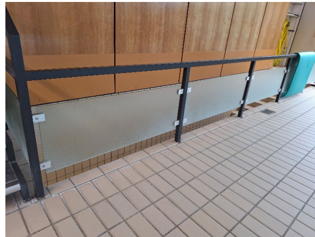
Abbildung 12: Geländer bei Treppenaufgang
