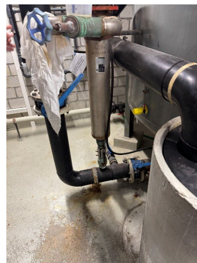
Abbildung 4: Wasseranschlüsse Filteranlage
