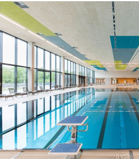
Abbildung 90: Runtergehängte Akustikdecke
