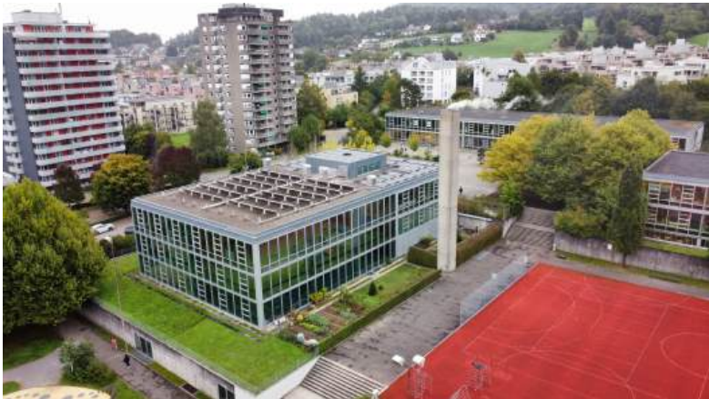
Foto Luftaufnahme Blickrichtung Osten bestehendes Schulhausgebäude
