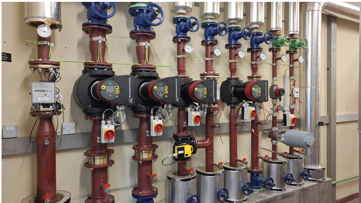
Abbildung 12: Neue Umwälzpumpen
