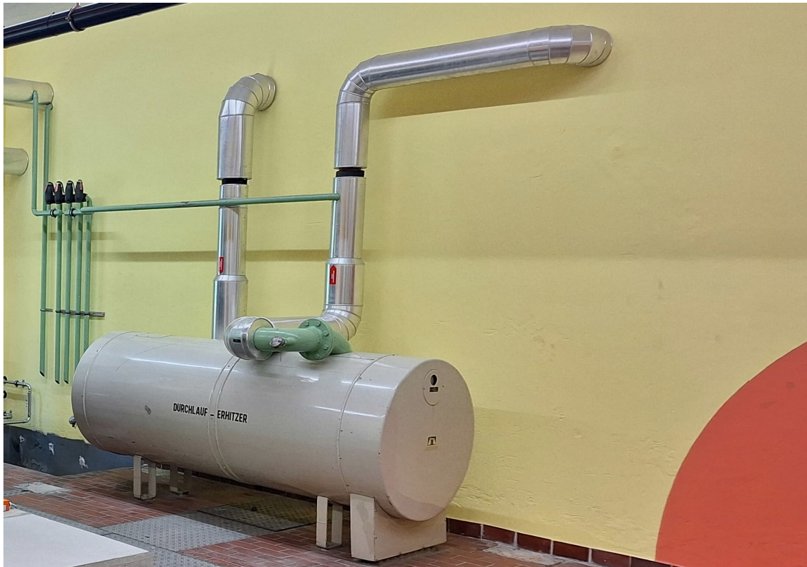
Abbildung 10: Bestehender Elektrodurchlauferhitzer
