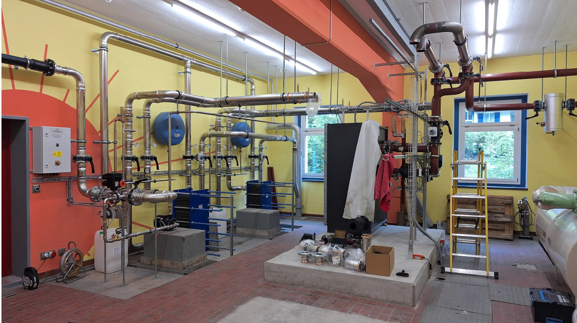
Abbildung 7: Heizraum während des Umbaus, 22.08.2025
