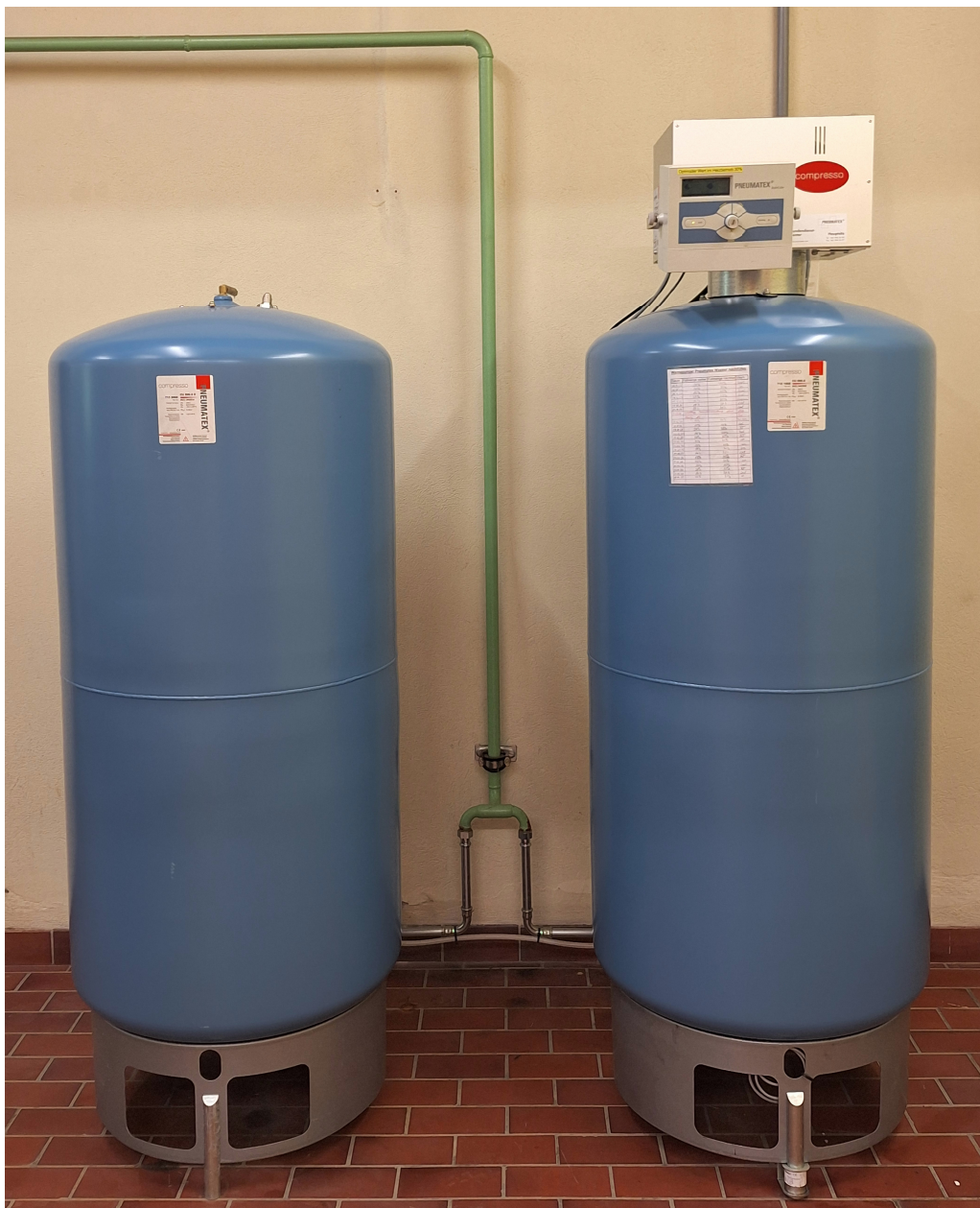
Abbildung 15: Bestehende Ausdehnungsgefässe
