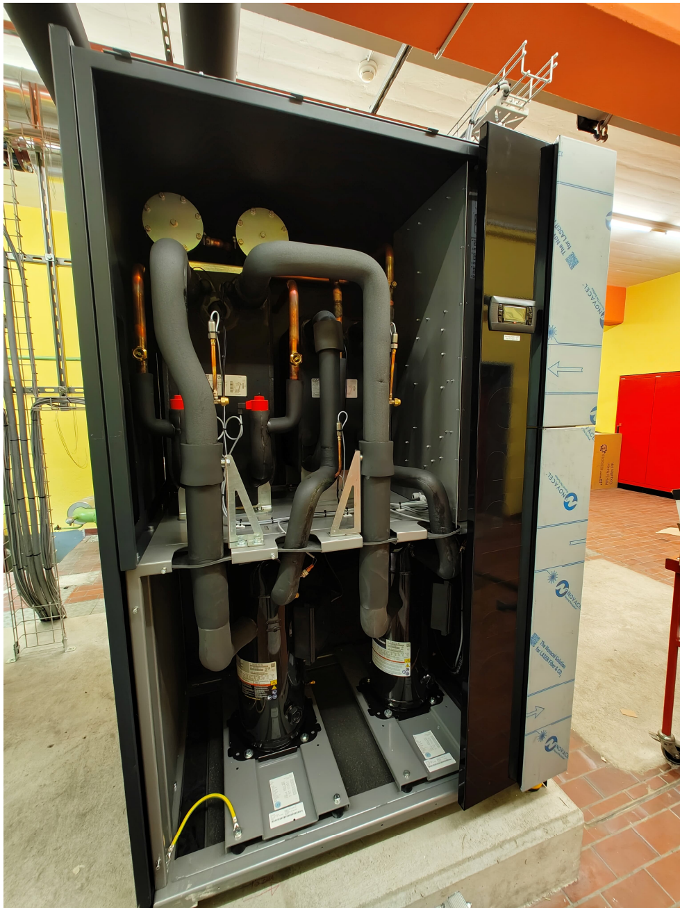
Abbildung 9: Neue Wärmepumpe während des Umbaus, 05.09.2025
