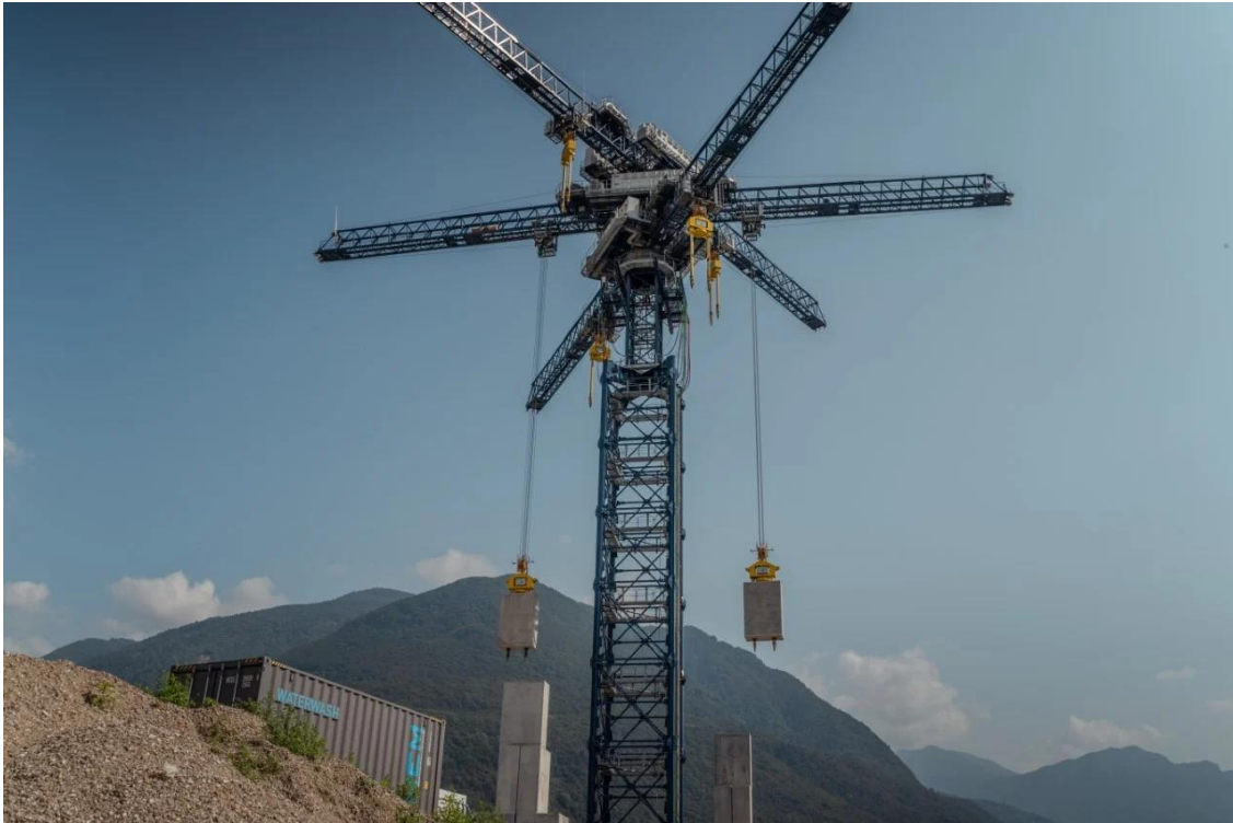
Abbildung 2 Kranaufbau eines Hubspeicherkraftwerkes
