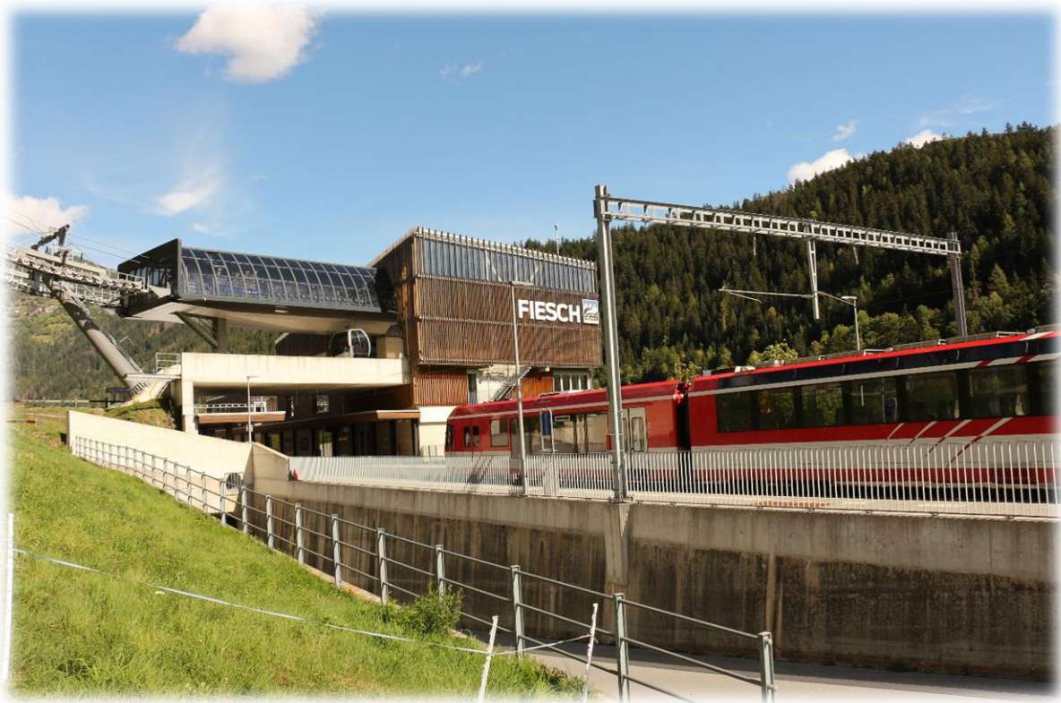
Abbildung 21 Einfahrt «Orion» der MGB in den ÖV-Hub Fiesch
