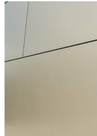
Fassade Sockelgeschoss Aluminiumverbundplatte Bronze
