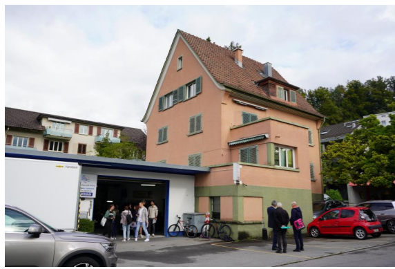
1) Best. Wohngebäude und Autolackierwerkstatt
