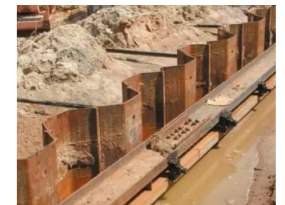
10) Stahlspundwände constructalia.arcelormittal.com
