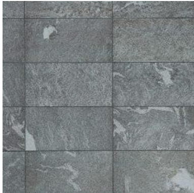
Bodenbelag Treppenhaus inkl. Treppe: Platten anthrazit 30x60cm
