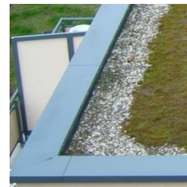
Flachdach: extensiv begrünt mit Kiesstreifen
