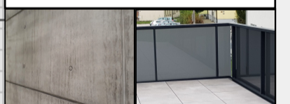
Stützmauer und Absturzsicherung
