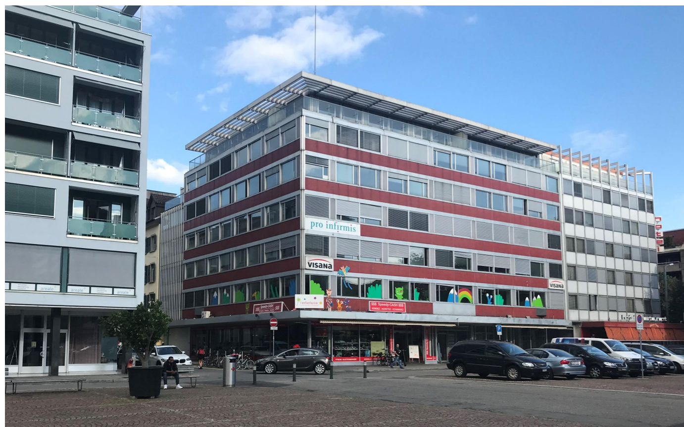
Aufnahme bestehendes Gewerbegebäude aus der Sicht vom Neumarktplatz
