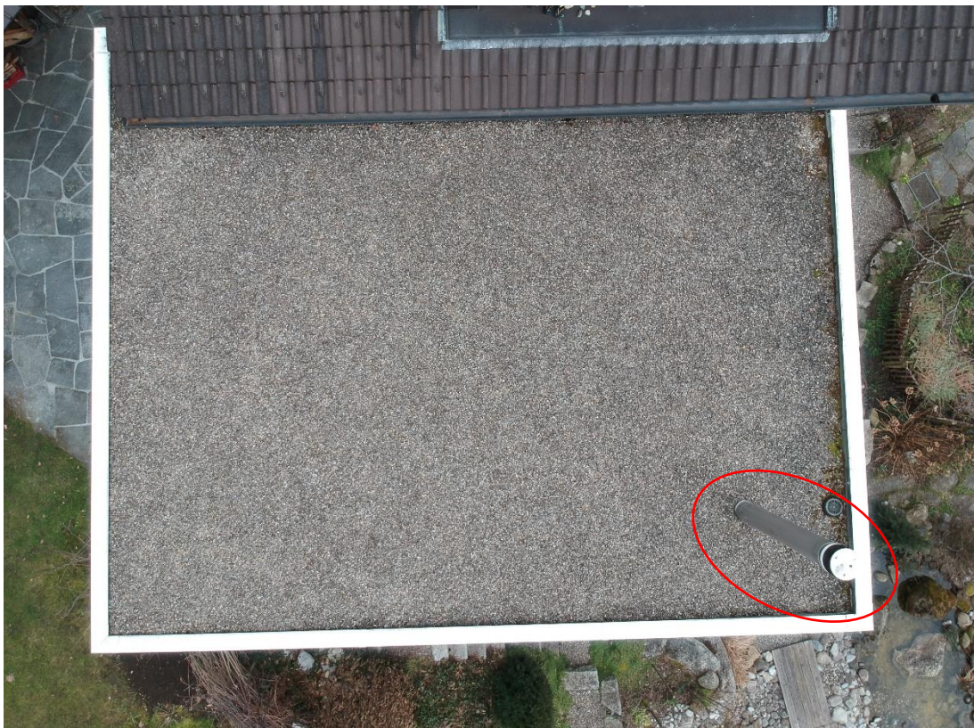
Abbildung 13: Drohnenaufnahme Flachdach Anbau
