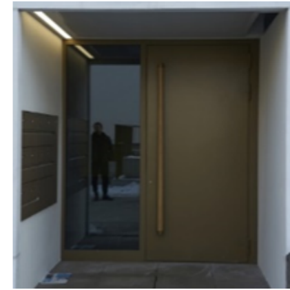
Notausgänge System: Metalltüre mit Glaseinsatz Verglasung: 3-fach Isolierverglasung U-Wert Glas: 0.7 W/m²K Oberfläche: einbrennlackiert (Rahmen und Türblatt) Farbe: NCS S 7005-Y20R (innen & aussen) Beschläge: Panikschloss SN EN 179
