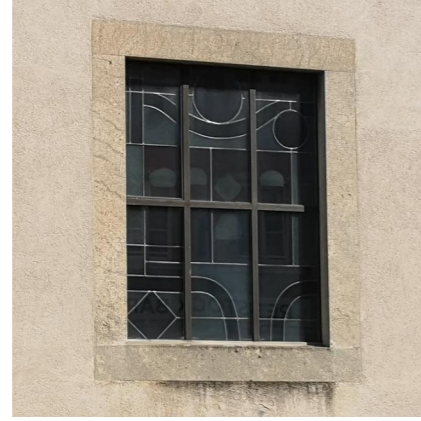
Fenster Dreilanzettig mit feingeschwungenen Flamboyant Motiven
