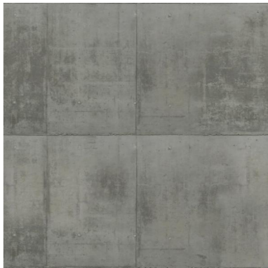
Sichtbeton vertikale Schalung Typ 4.3
