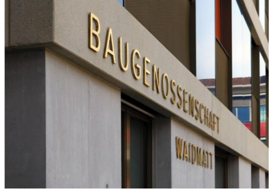
Schriftzug Fassade Messing
