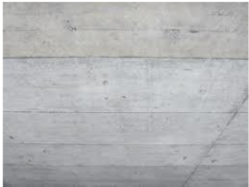
Sichtbeton Technik und Waschen
