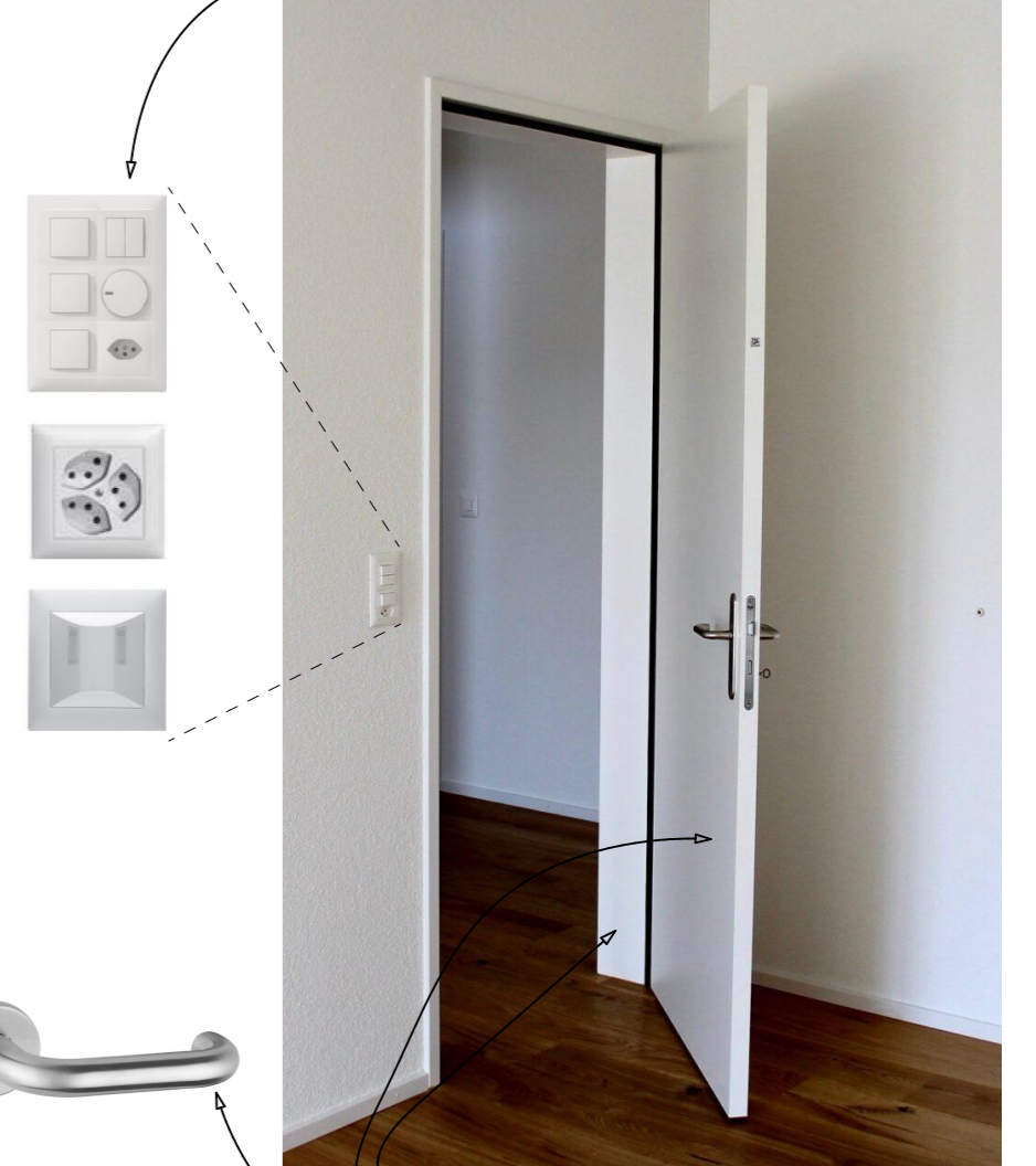
Türrahmen Metallzarge RAL 9016 Türblatt RAL 9016 Türdrücker Edelstahl 5064 Oslo Langschild Edelstahl 31345 Topaz
