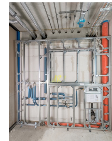
Wandkonstruktion Nasszellen
