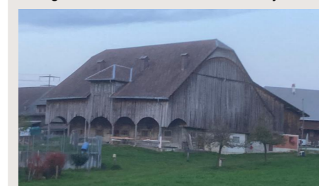
Auch die Anforderungen an den Sommerlichen Wärmeschutz sind erfüllt. Die Fenster werden mit Verbundrafflamellenstoren verdunkelt.
