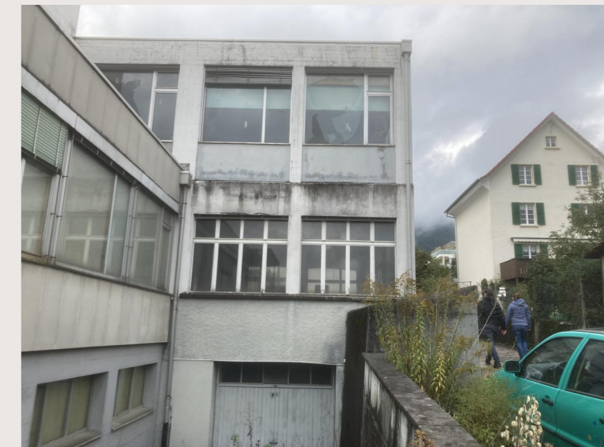
Bestehendes Gewerbegebäude an Bettlachstrasse
