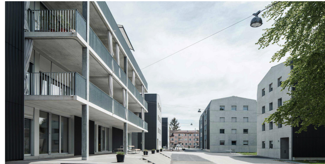
Siedlung Narzissenweg, Biel
