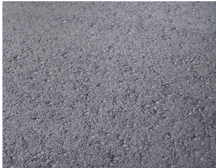
Belag Zufahrtsstrasse Asphalt
