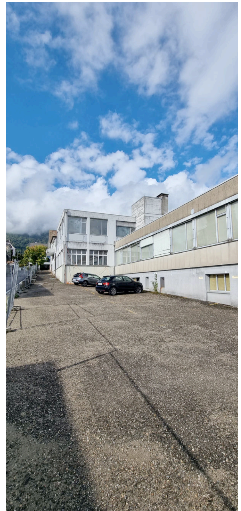
Das bestehende Gewerbegebäude
