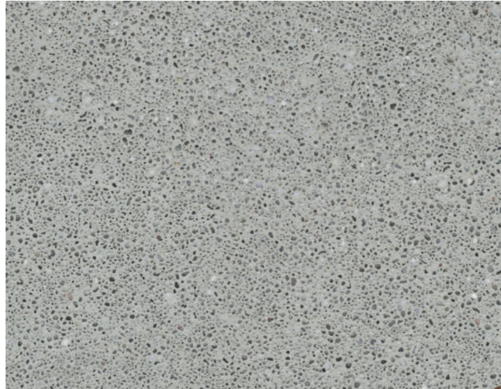
Bodenbeläge Untergeschoss Hartbeton geschliffen
